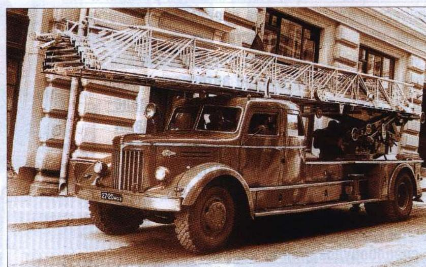
2. 45-метровая пожарная лестница АЛМ-45 (200) модели «Л» на шасси МАЗ-200 изготавливалась с 1961 по 1964 г. Торжокским заводом противопожарного оборудования Московского Станкозавода. Фото автора
